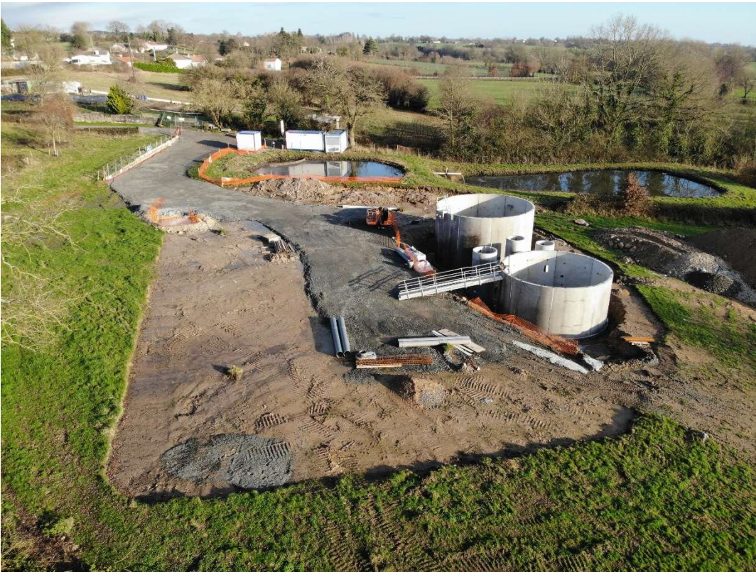
Travaux de construction de la nouvelle station d'épuration du Pin
